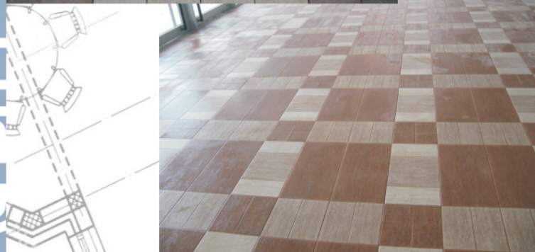
Ugradnja keramičkih pločica
