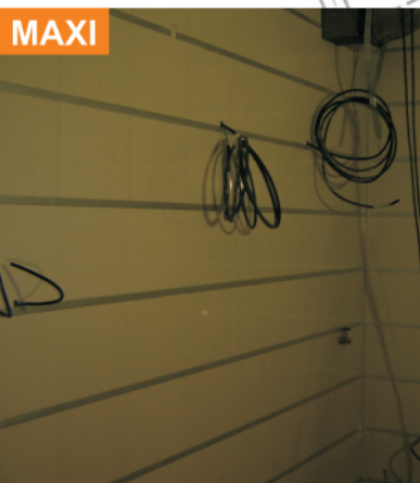
Ugradnja keramičkih pločica
