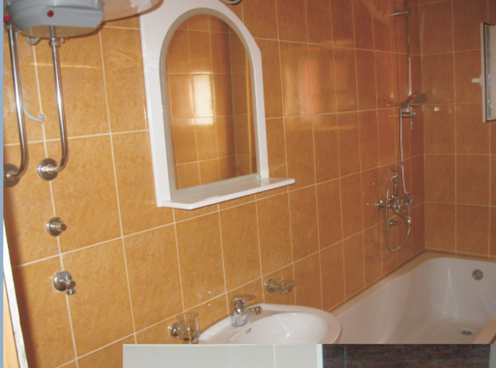
Ugradnja keramičkih pločica
